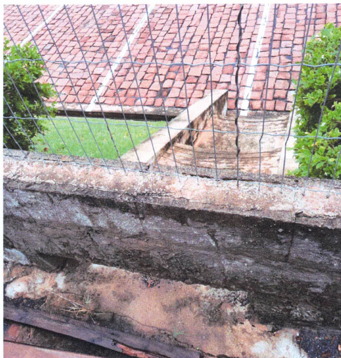
Foto 03 – Vista de cima da saída de água existente
