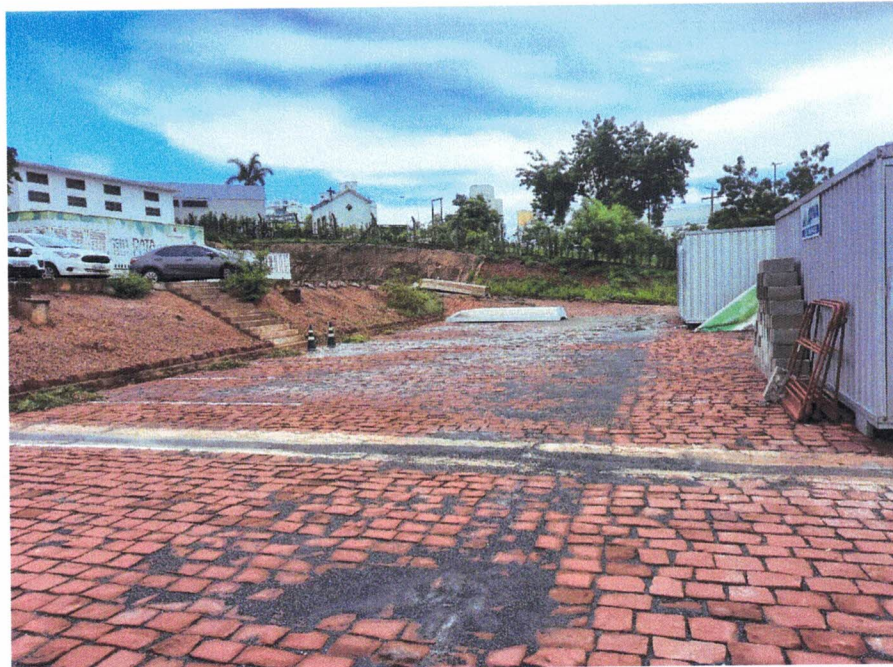
Foto 01 – Vista da canaleta de drenagem existente
