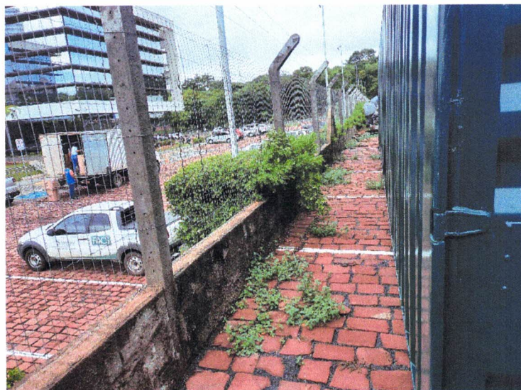
Foto 04 - Mureta existente de limite do terreno
