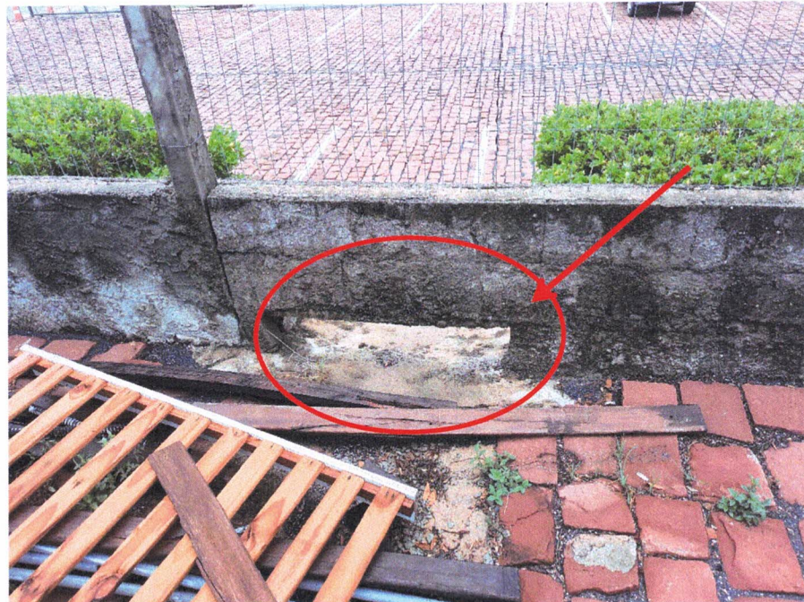
Foto 02 – Vista frontal da saída de água existente
